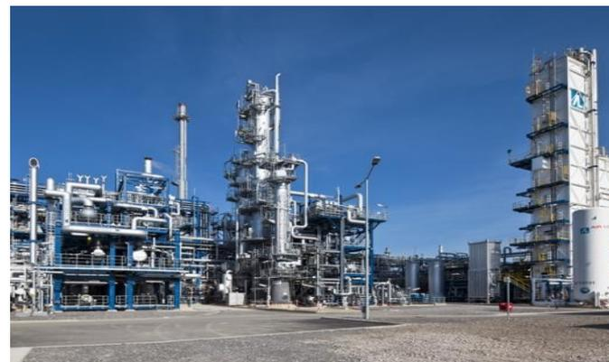
*Impianto per la produzione di 22.000 t/anno di idrogeno da steam reforming del metano nei pressi di Colonia (DE).Fonte: Air Liquide, 2015*
